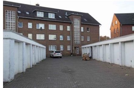
Garagenhof Tilsiter Straße
